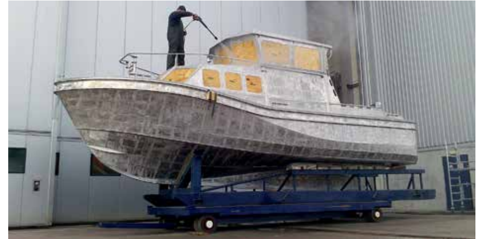
Erstmals Wasser gespürt: Der Kaskobau des neuen Seenotrettungsbootes SRB 65 ist abgeschlossen. Auf dem Waschplatz der Tamsen-Werft wird das Boot im Herbst 2014 gereinigt, anschließend gesandstrahlt, dann erneut gewaschen und getrocknet.
